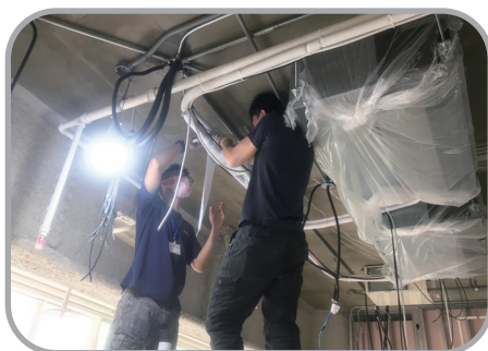
冷氣管路裝修
